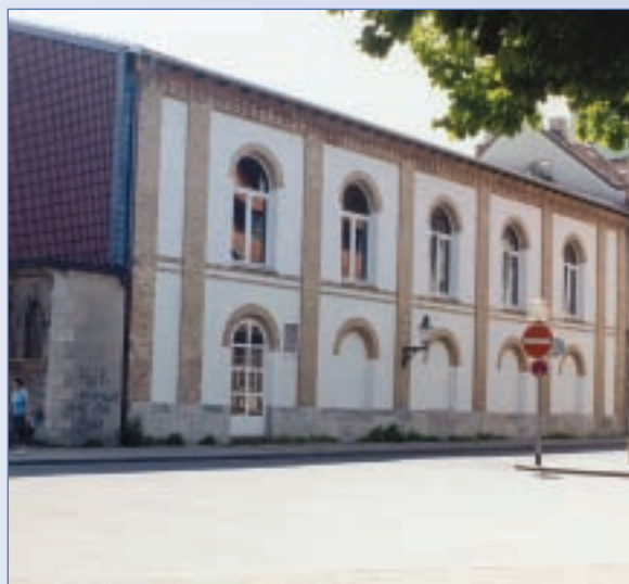
Sanierung einer denkmalgeschützten Halle
