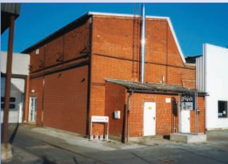
Umwidmung einer Lagerhalle in eine moderne Vereinssportanlage
